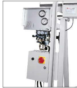
Particolare del quadro comandi.
